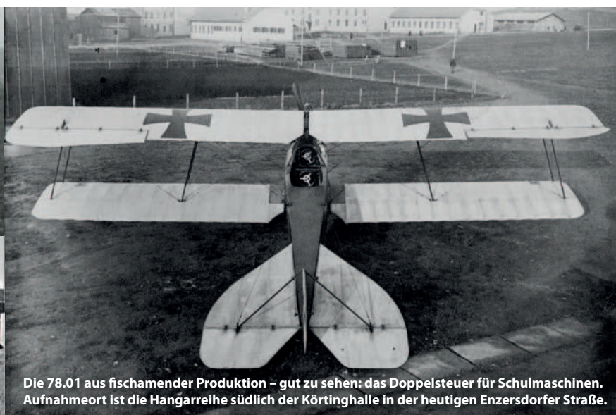
Eine Reihe „Brandenburger“ auf dem Flugfeld, dahinter der noch eingerüstete Wasserturm Anfang 1917 und die Hangars entlang des ebenen Verlaufs der Flugfeldstraße.
